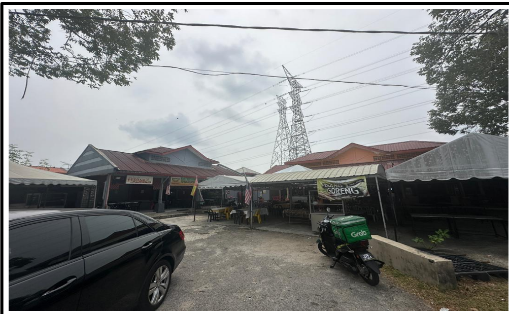
PANDANGAN HADAPAN MEDAN SELERA JALAN RAYA 6, SERDANG JAYA
