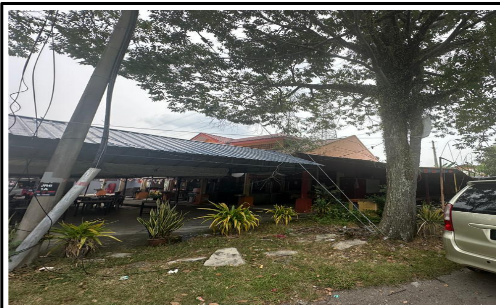
PANDANGAN SISI MEDAN SELERA JALAN RAYA 6, SERDANG JAYA
